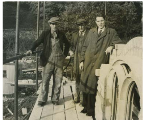
Y PARCH. ELFED DAVIES A DAU WEITHIWR I FYNY AR Y SGAFFALDIAU
